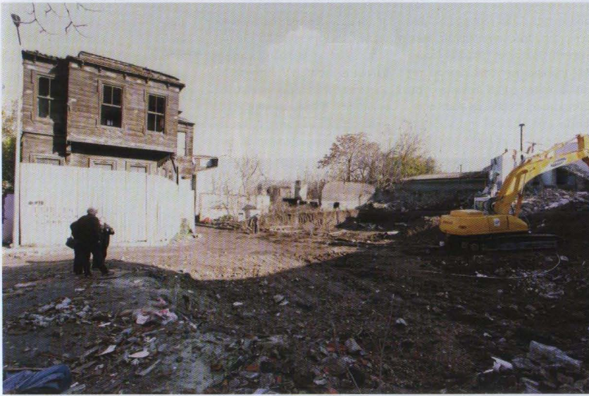
Tokludedede'de yıkım çalışmaları.
