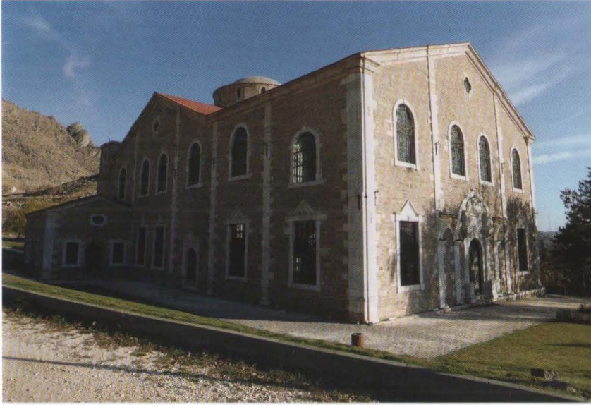
Resim 2 Sivrihisar, Ermeni Kilisesi, onarımından sonra kuzey- batı ana cephe, 2016.
