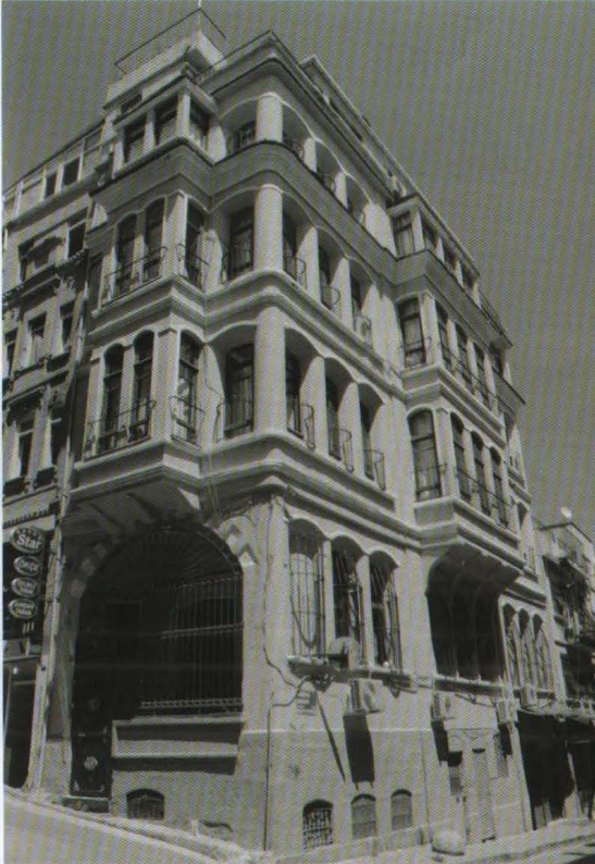
1865 Hocapaşa yangın yeri düzenlemelerinden sonra yapılan, Kadırga Hamamı ve Nevliyye Sokaklarının kesiştiği köşede yer alan dönemin çok katlı kâgır binalarından.
