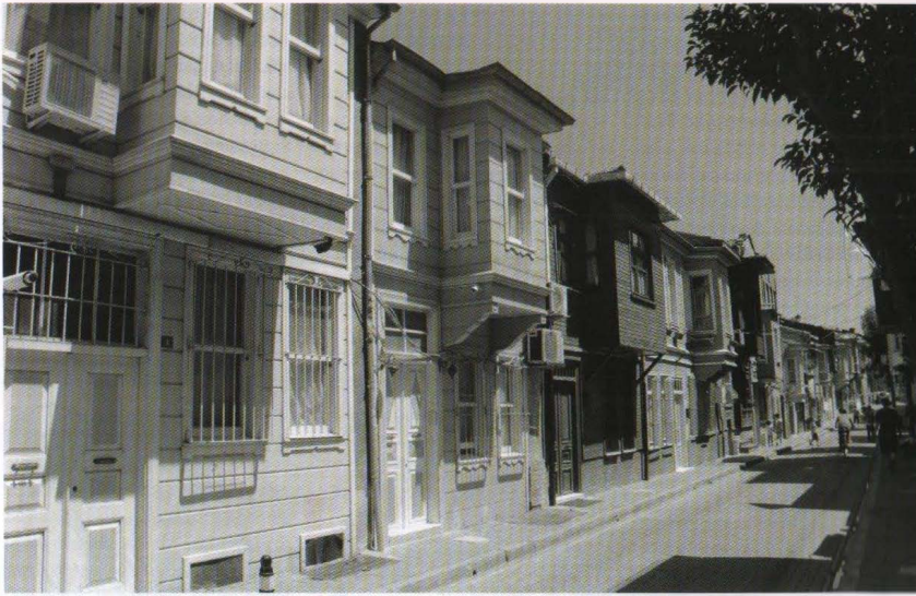
1865 Hocaapaş yangın yerl düzenlemele- rinde yeni açılan eksen (günümüzdeki ismiyle Şehsuvar Bey Sokak) üzerinde aralarındaki yangın duvarıyla inşa edilmiş olan ahşap sıra evler.
