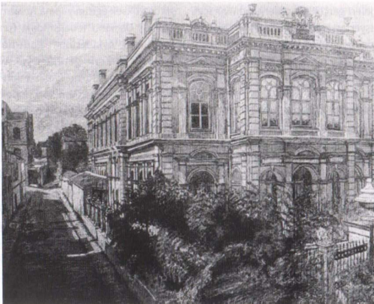
İnas Darülfünunu 1916-1917 ders yılında eski Hukuk Mektebi (Mekteb-i Hukuk-i Şahane) binasında hizmet verdi. Bu bina sadece kadın öğrencilere aitti. 1918-1919 ders yılında ise, yeniden Zeynep Hanım Konağı'na geri döndü.
