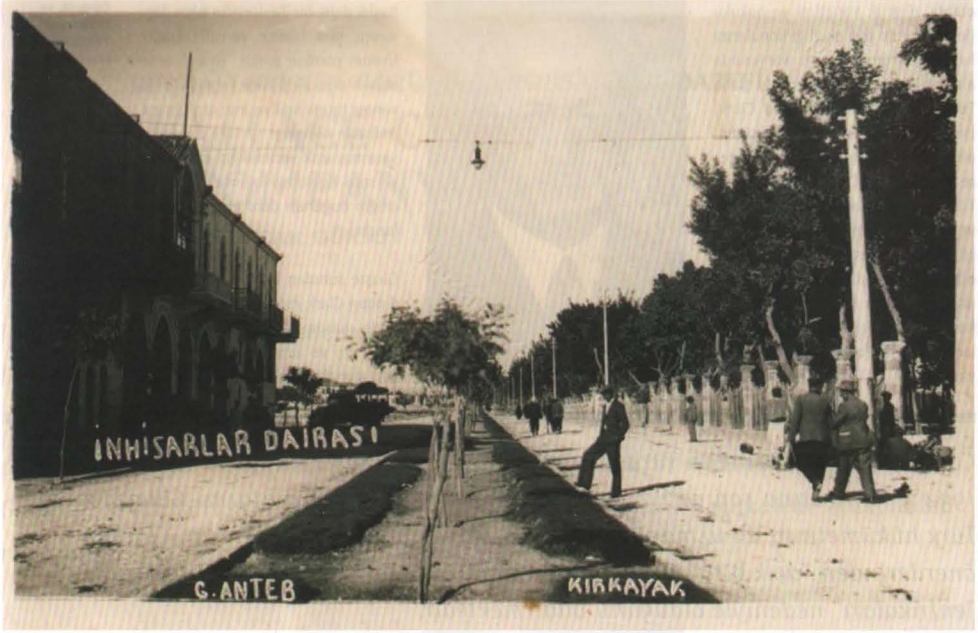
İnhisarlar İdaresi Gaziantep binası.
