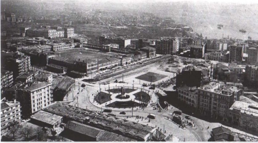
Taksim Meydanı ve Kışla (solda).
