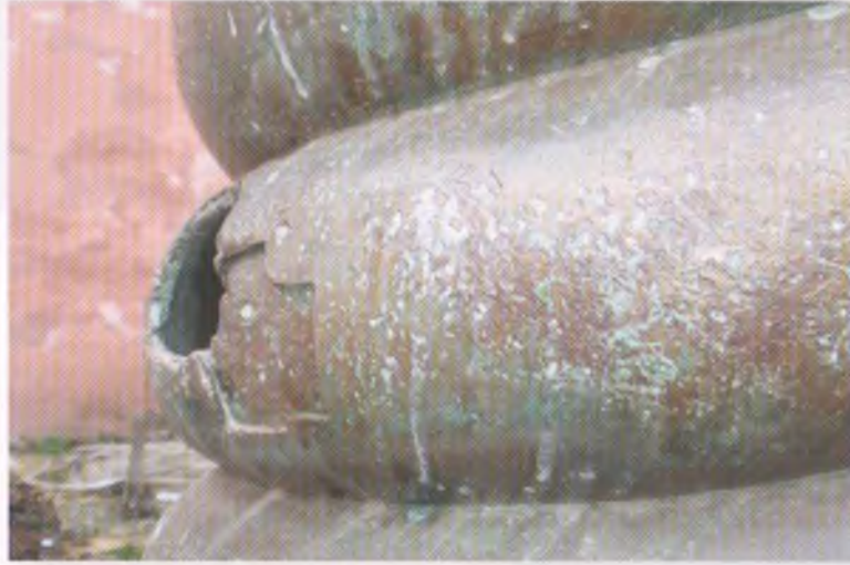
Res. 13: Yılanlı Sütun üzerindeki dökümden kaynaklı kusur ve onarım izi.
