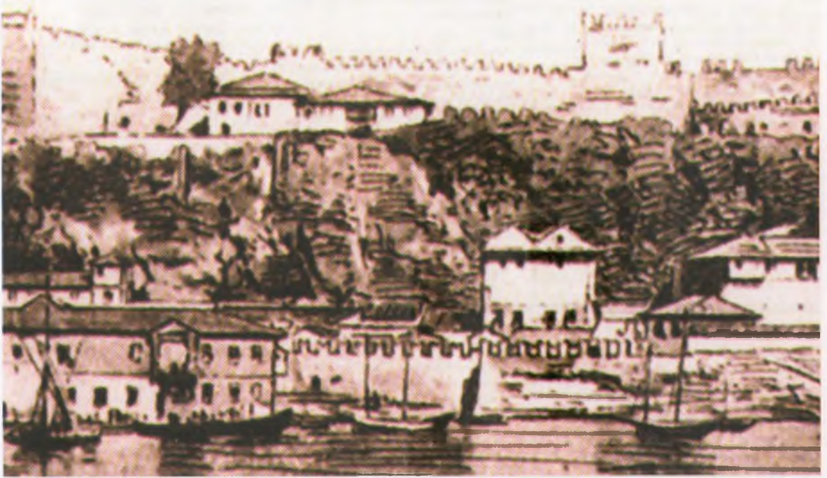
Res. 1: Dikkat çekici, mazgal şeklindeki siperleriyle Antalya Mina sur duvarları.
