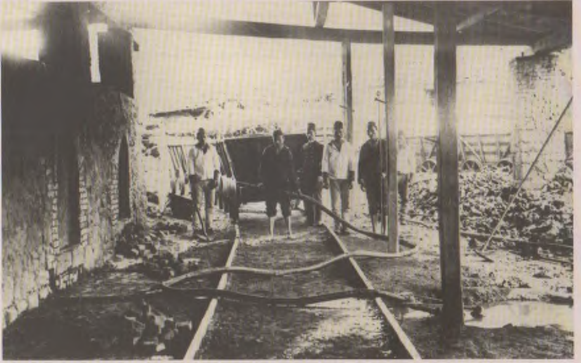
Kok kömürü üretiminin yapıldığı bir fırının içerden görünüşü, Zonguldak (20. yüzyıl başı).
