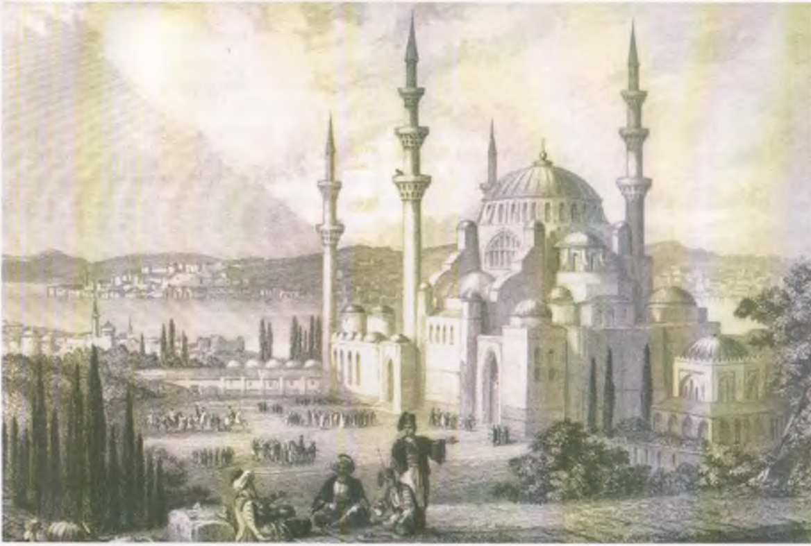
Süleymaniye Camii. Sinan külliye avlularında kentin algılanabilmesine olanak veren manzara noktaları tasarlamıştır. Bu amaçla Süleymaniye dış avlusundan Haliç ve Boğaz'a bir bakış güzergâhı oluşturmuştur.
