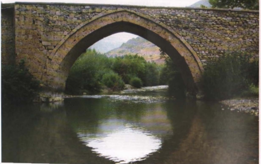
Malatya'nın Arapkir ilçesinde ve Kozluk Çayı'nın üzerinde yer alan Meydan Köprüsü.
