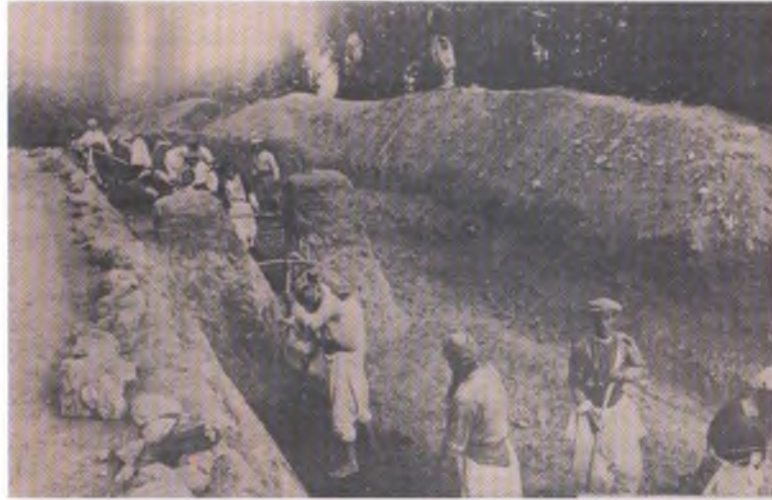
Tunceli'de yol inşaatında çalışan köylüler.
