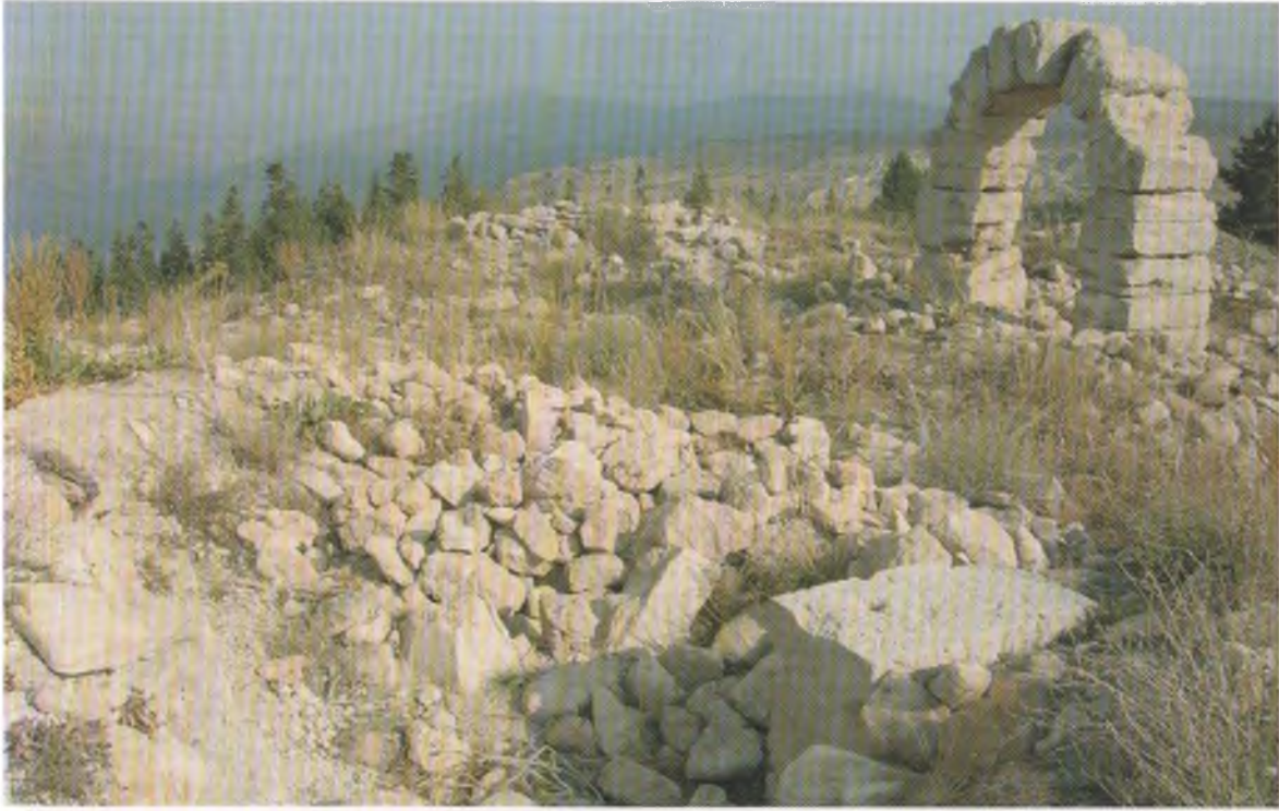
Kilisenin kemerine ve 2008'de sökülen taşıyıcı ayağına kuzeyden bakış.
