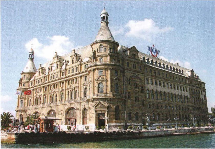
İstanbul'un simgelerinden olan Haydarpaşa Garı yakın gelecekte boşaltılıp cephesi hariç tamamı yıkılarak yeni İstanbul limanı projesi kapsamında otel olarak yeniden inşa edilecek.
