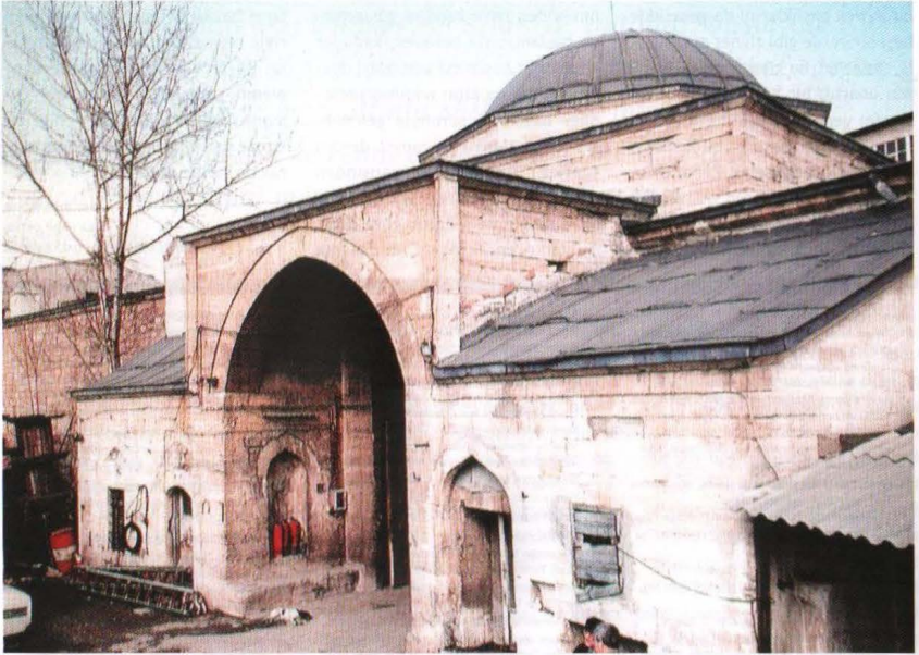
Ayşekadın Kervansarayı'nın girişi.
