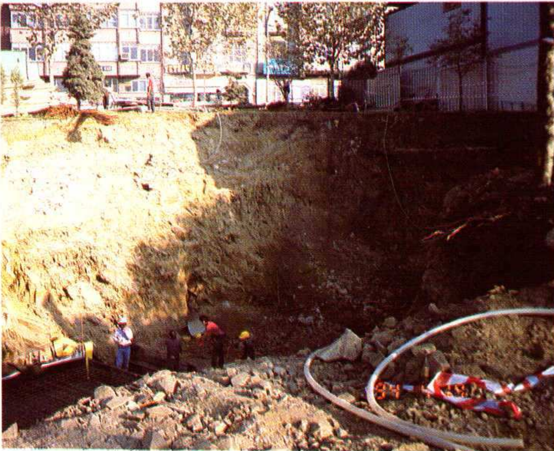
İstanbul, Şişhane metro kazısı, 4 Kasım 2000.
