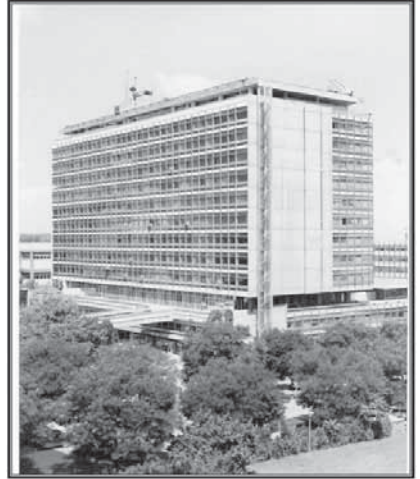
DSİ Genel Müdürlüğü Binası
