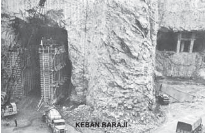
Keban Barajı İnşaatı
