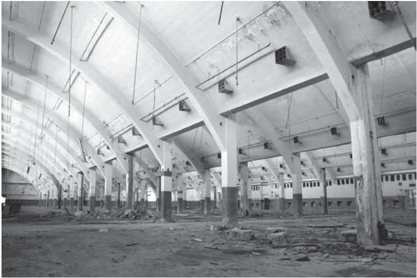
İşletme Binasının İçi, 2011
