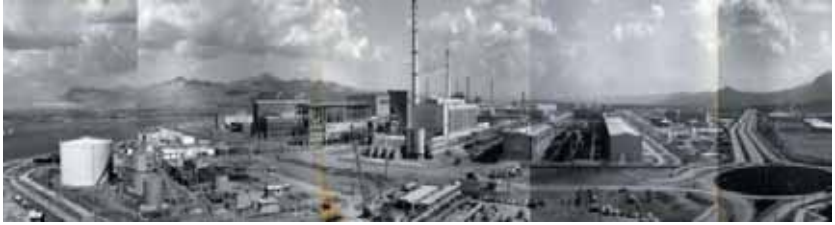
ETİBANK Seydişehir Alüminyum İşletmeleri'nden Genel Bir Görünüm
