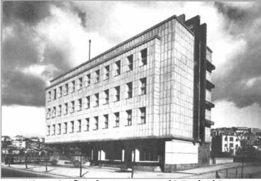
Mimar Seyfi Arıkan'ın yaptığı eski Banka binası
