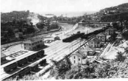
Zonguldak istasyonu yapım çalışmaları. (1937)
