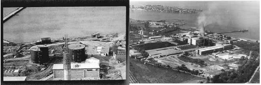
Çayırova’daki düzcam fabrikasının yapım aşamaları ve bugünkü durumu
