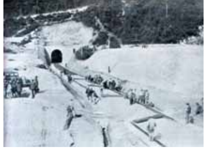
Tünel ağzında balast deposu
