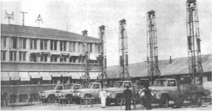
MTA'nın ilk yıllarındaki Ankara-Akköprü tesisleri
