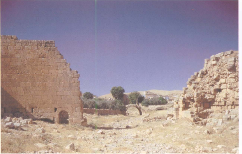
77. Dara kalekentine giriş kapısının kalıntıları.
