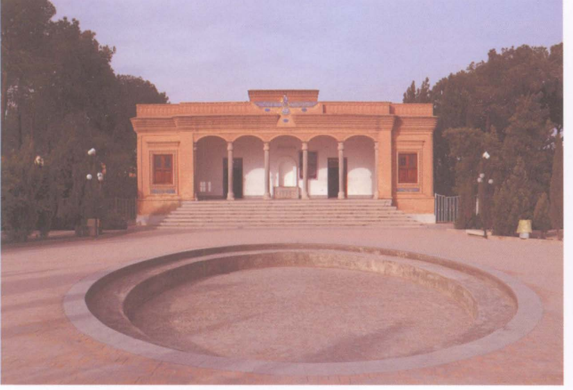
86. Yazd'de modern bir Zerdüştcülük ateş tapınağı.
