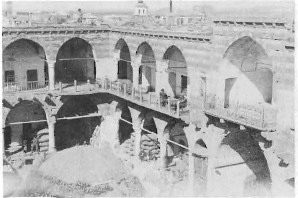
RESİM 2. Hanın avlu görünüşü. İki katlı revaklar ve yolcu odaları.
