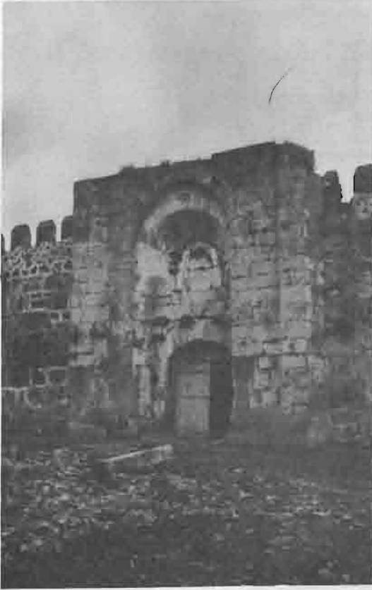
RESİM 3. Hanın giriş kapısı.
