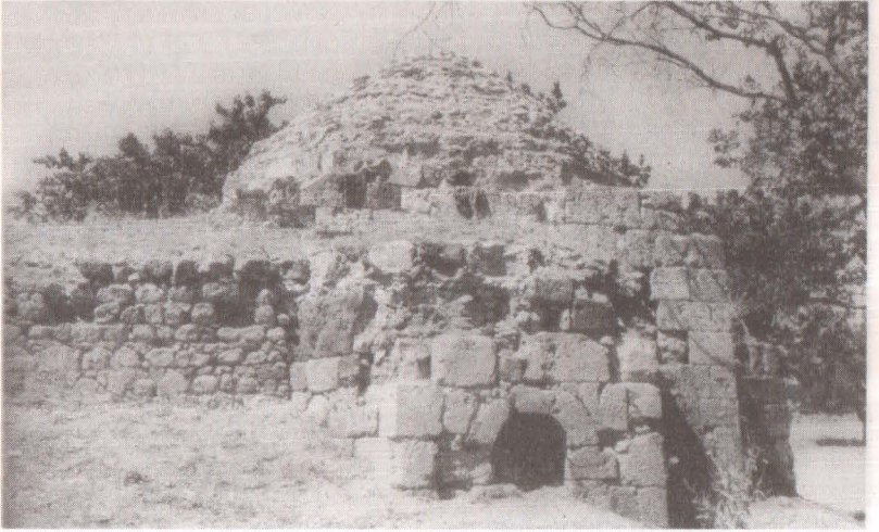
Şekil 8: Tadım Manastırı: Güney dış cephe
