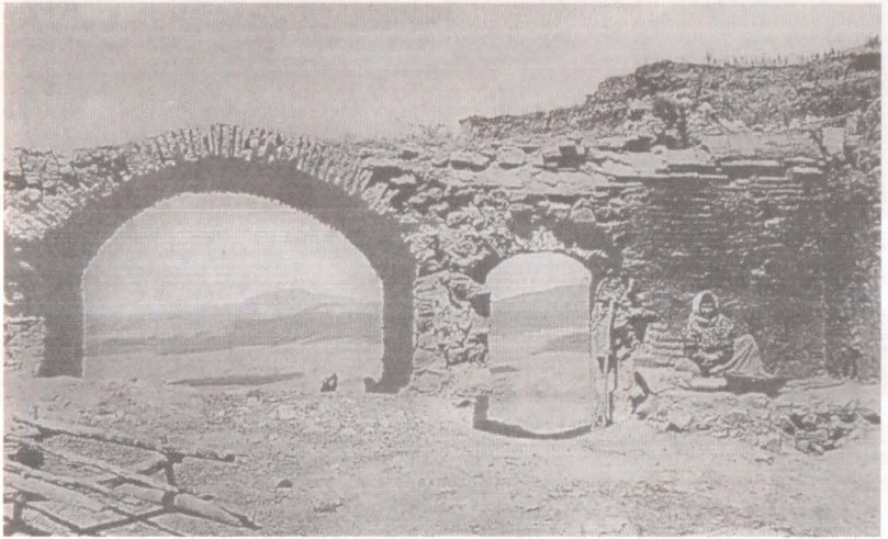
Asdvadzadzin Şapeli'nin yıkıntıları, Surp Garabed
