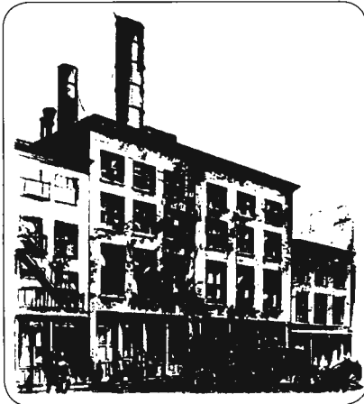
New York Manhattan'da, Edison tarafından hayata geçirilen Pearl Caddesi Doğru Akım Santrali'ne ( Pearl Street Direct Current Generating Station ) ait bir çizim
