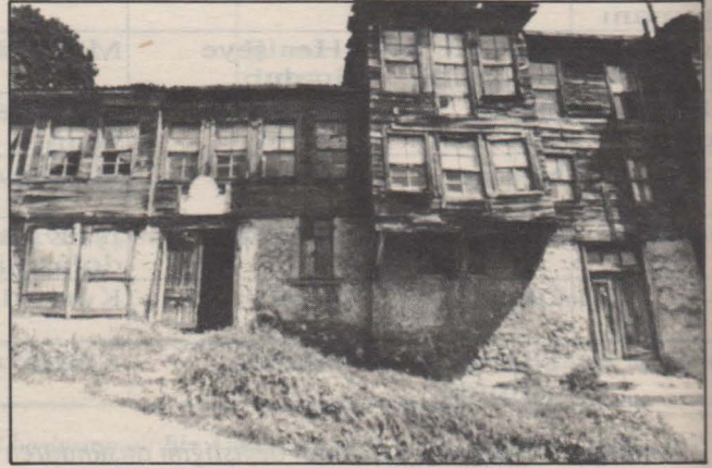
Tekkenin selâmlık bölümü, restorasyondan önce, restorasyondan sonra.
