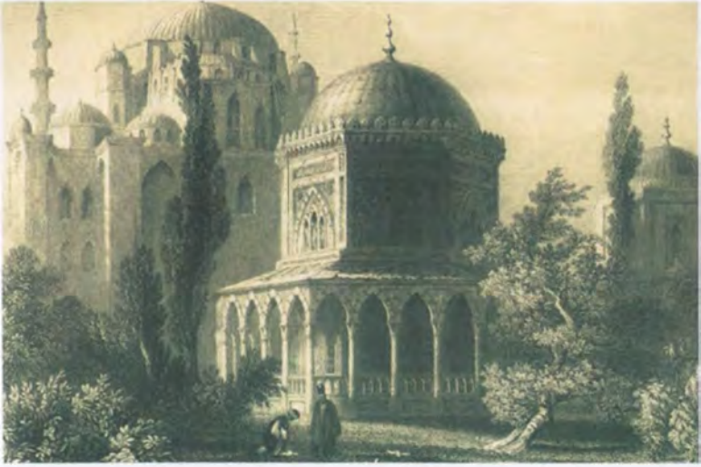
Süleymaniye Cami kible tarafında Sultan Süleyman ve Hürrem Sultan türbeleri
