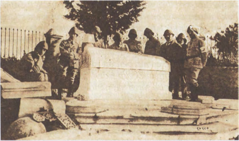
Namık Kemal'in Bolayır'da, Süleyman Paşa'nın kabrinin yakınlarında bulunan ve düşman kurşunları tarafından zarar gören kabri.
