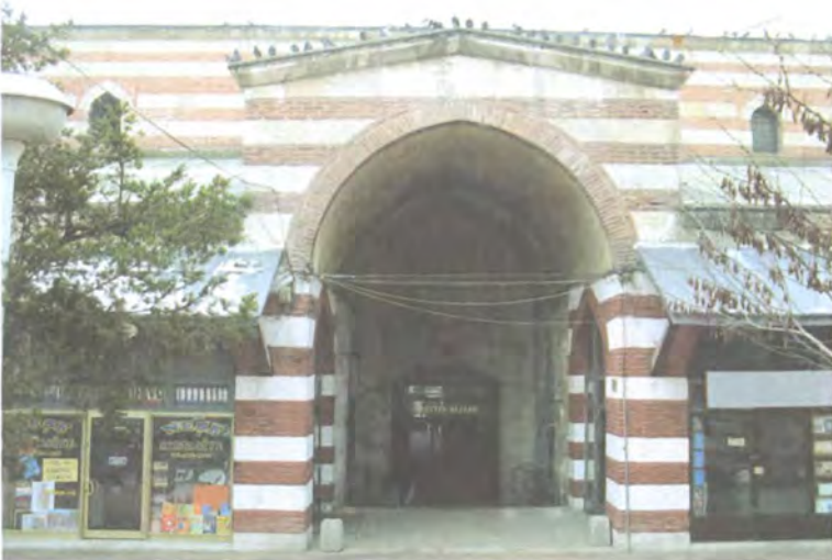
Bedesten'in yan giriş kapısı.
