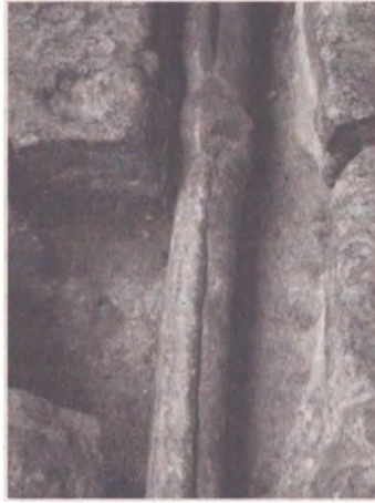
Şekil 10.5. İngiltere’de Bath’daki Aquae Sylis ’te Roma devrinden kalma bir kurşun boru.
