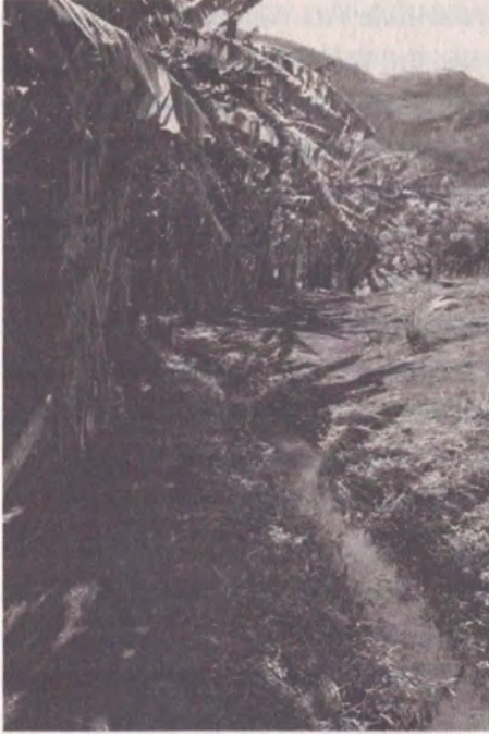
Şekil 3.1. Wei Wei Irmağı'ndan başlayıp vadinin zemininden geçerek mısır tarlalarına ve muz çiftliklerine ulaşan bir Pokot arıkla sulama sistemi. Arığın uzunluğu 3 kilometreden fazla; başlangıç noktasında taş ve çalıdan yapılmış bir toplama barajı ve geniş bir taş duvarı var. (Nairobi'de Doğu Afrika'daki British Institute'den Matthew Davis'in izniyle.)
