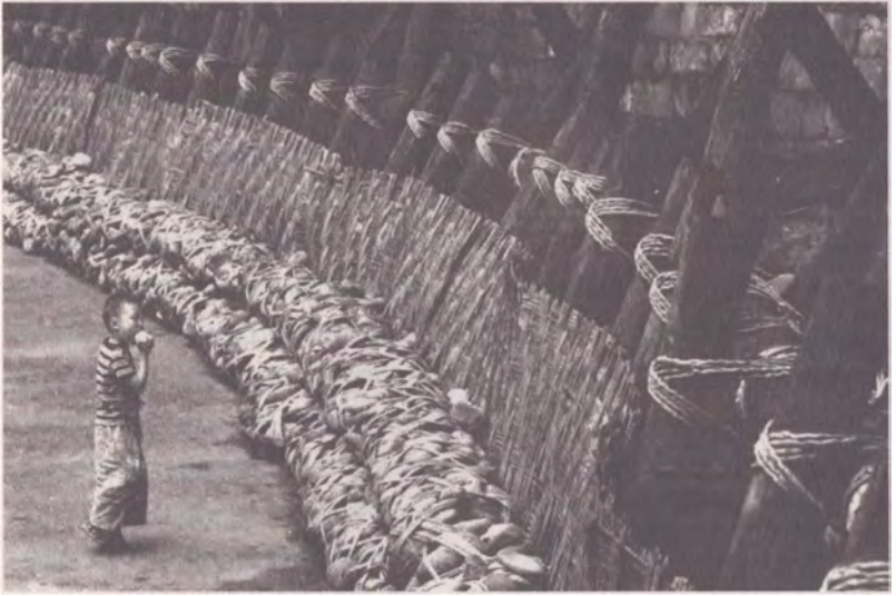
Şekil 12.2. Dusiangyan. Genç bir ziyaretçi Min Irmağı üzerindeki sulama sisteminin bir bölümünü oluşturan ağaçtan yapılmış uçayakları ve taşlarla dolu bambu sepetleri inceliyor. (Bobby Yip/Corbis)
