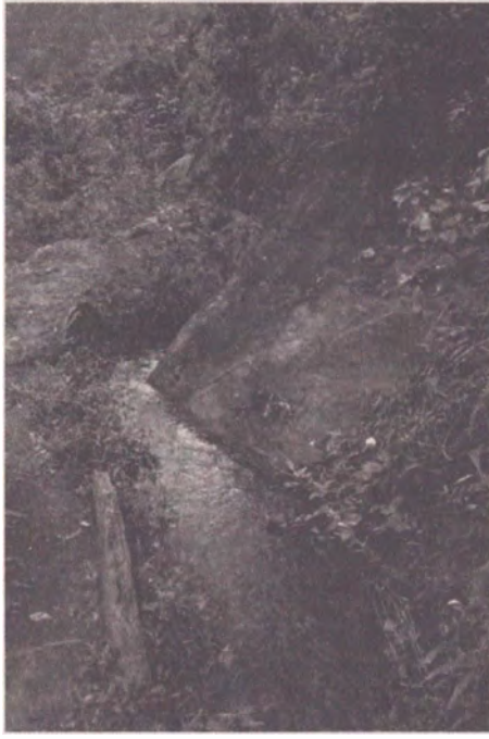
Şekil 3.2. Wei Wei Vadisi’ndeki Tororo Irmağı’nda yer alan bir başka Pukot arığı. Bu arık vadinin kenarında 4 kilometre boyunca yol olarak birçok mısır tarlasına su sağlıyor. Özellikle yukarı kesimde son derece sağlam bir yapıya sahip; büyük taş bloklar arkın aşağı eğimine destek oluyor. (Nairobi’de Doğu Afrika’daki British Institute’den Matthew Davies’in izniyle.)
