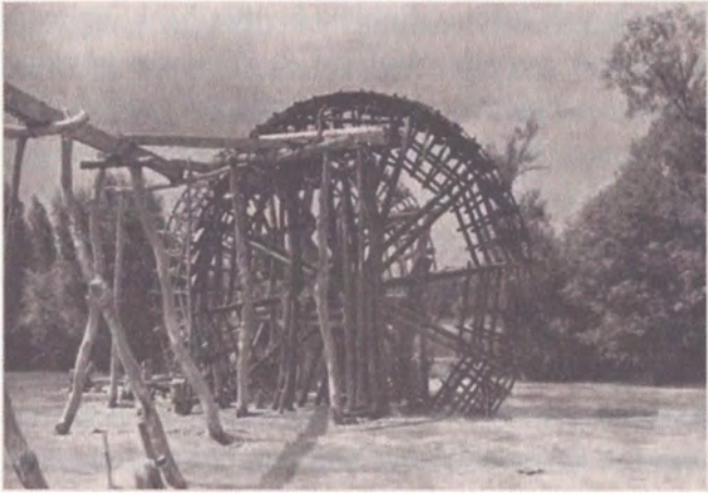
Şekil 12.5. 1940'larda Joseph Needham tarafından fotoğraflanan high-lift (?) norias. (Yazarın Science and Civilization in China kitabından, s. 312. Cambridge University Press'in izniyle.)
