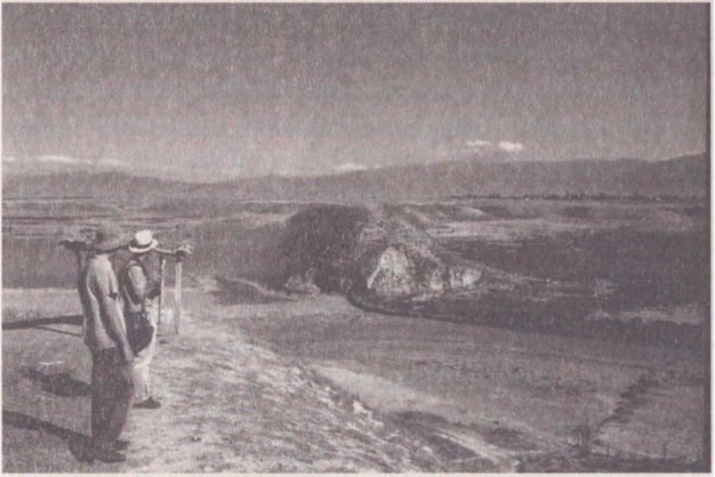
Şekil 8.4. İran'ın kuzeyindeki Sasani su şebekesi. Sadd I Garkaz, suyu Gorgan Nehri boyunca yanındaki hendeğe yönlendiren, topraktan yapılmış büyük bir su kemeridir. (Tony Wilkinson'un izniyle.)
