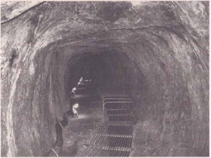
Şekil 9.2. Samos'ta Eupalinos'un yaptığı tünel. Su sağdaki hendekten akıyordu.
