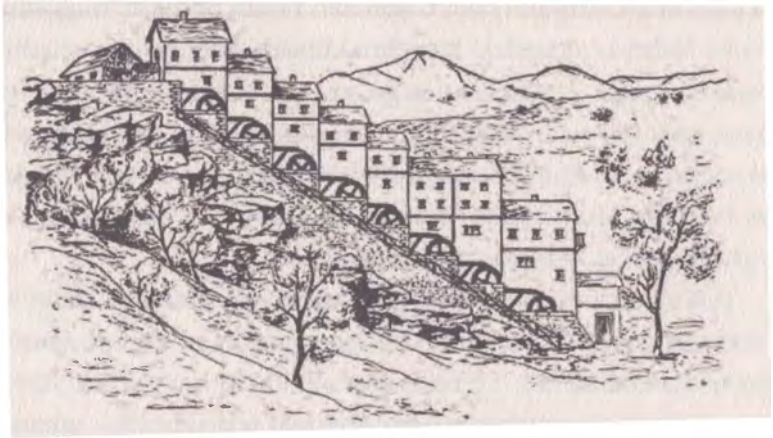
Şekil 16.1. Roma’da sınav buğday öğütülmesi. Fransa’da, Arles yakınındaki Barbegal’da su kemeri ile beslenen iki sıra halinde kademeli on altı su değirmeninde 12.500 kişiye yetecek kadar un öğütülüyordu (A. Trevor Hodge’un Roman Aqueducts and Water Supply eserinden. Copyright. 2002 by Duckworth & Co., Londra)
