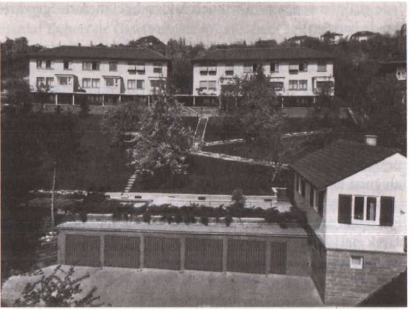
Griesinger'in Schottstrasse'deki evi, 1936 dolaylarında ( Moderne Bauformen , Eylül 1936, s. 499).
