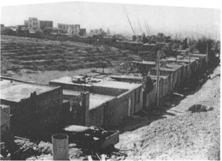
Hak-i Sefid gecekondu yerleşimi, Tahran, 1986 / Tahran Üniversitesi Mimarlık ve Mühendislik Fakültesi'nden bir öğrenci tarafından çekilmiştir.
