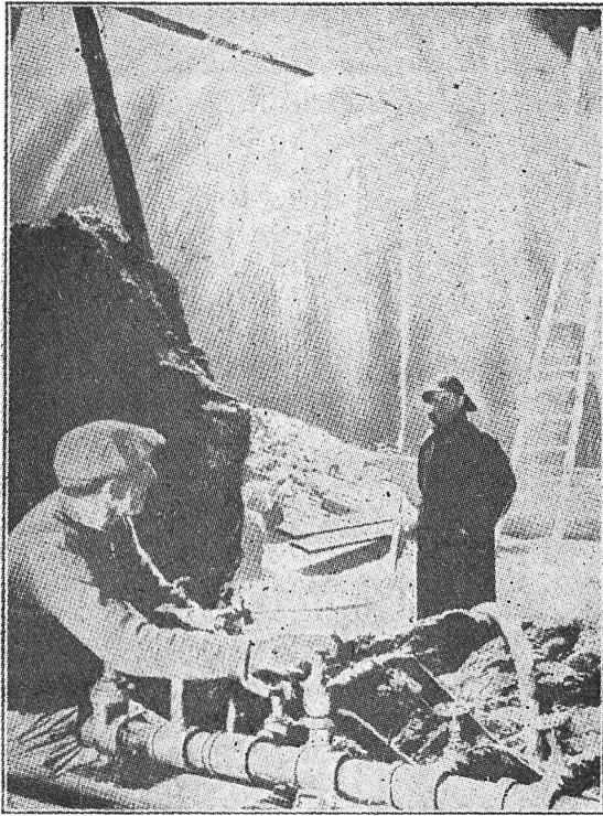
YAĞMUR. Merdivenler üzerine yerleştirilen delikli borulardan sular fışkırırken, bir işçi de anahtarları açıp kapayarak basıncı düzenliyor.
