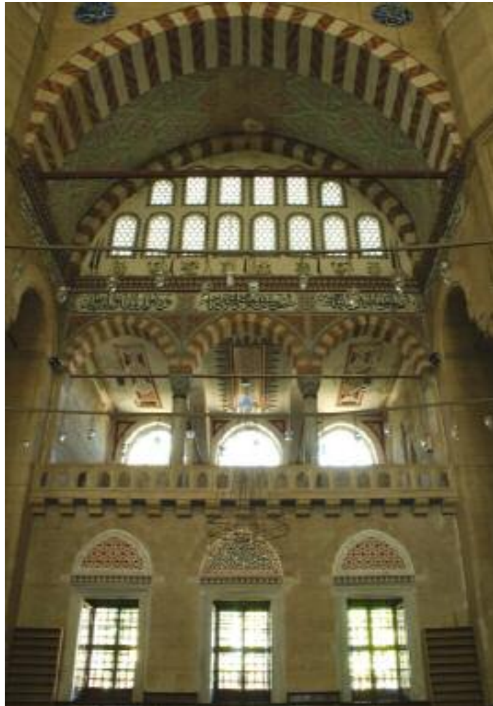
283 Edirne Selimiye Camii Sivri köşe kubbeleri ve dik eğimli destekler
