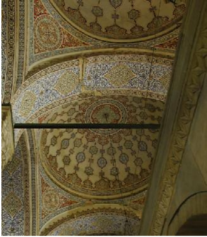
171, 172 Edirnekapı Mihrimah Sultan Camii Bütünlüğe sahip kalem işleri
