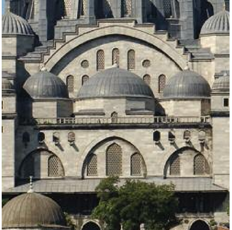
134 Süleymaniye Külliyesi Büyük kemerin altındaki boşluğun önünde, orta kubbenin iki yanındaki küçük kubbelerle yer alarak büyük kemere farklı bir boyut kazandırır. Merkezî kubbenin dört köşesindeki fil ayakları ve destek kuleleri, kemer ve kubbelerin kavisli yere dönük ifadeleriyle dengelenir
