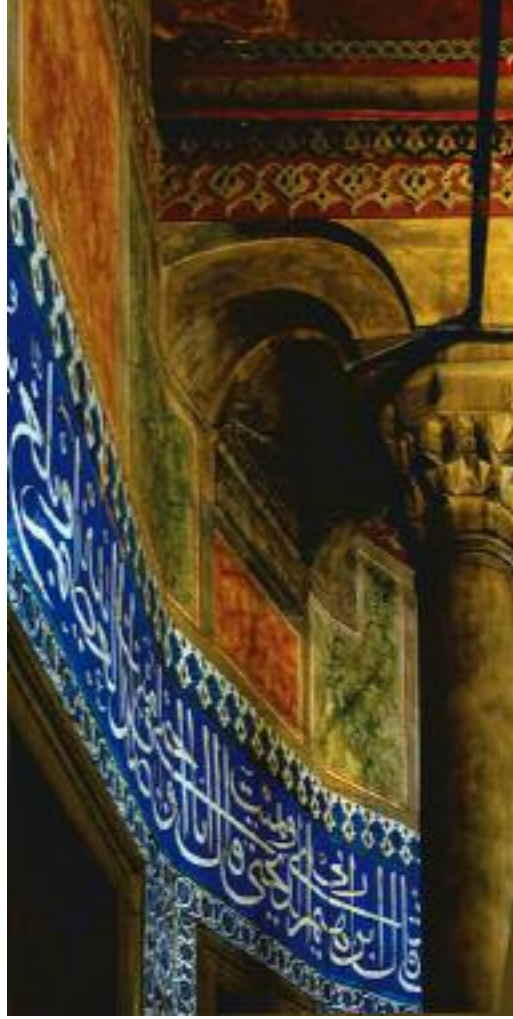
112 Kanuni Sultan Süleyman Türbesi İç görünüm, dış duvarlardan bağımsız olarak kubbeyi taşıyan mukarnaslı sütunlar
