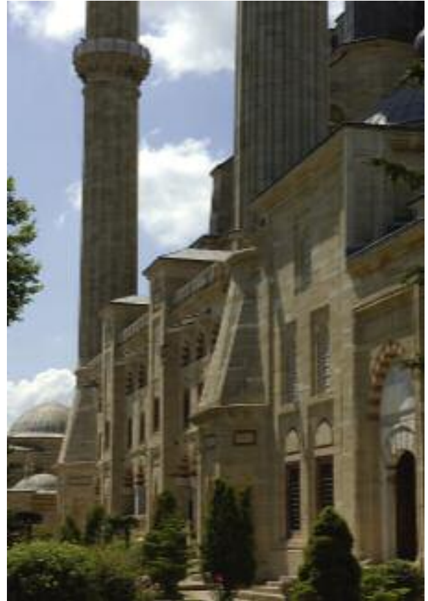
274, 275, 276 Edirne Selimiye Camii Fil ayaklarıyla birleşerek merkezî kubbeyi taşıyan destekleme sistemi
