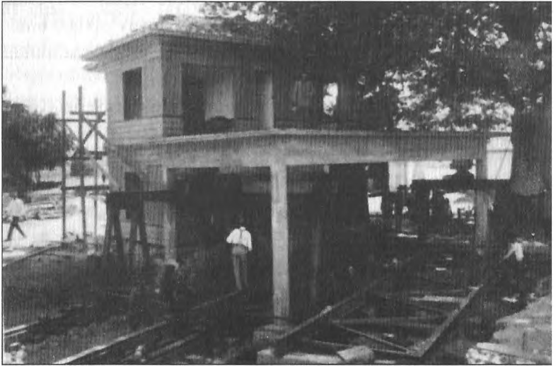
Köşkün altına ray döşeme çalışmaları
