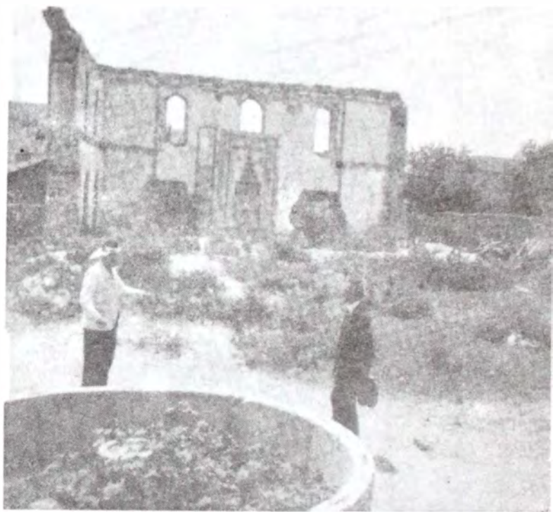
Üçüncü resim: Türbenin arkasındaki Kadirî tekkesinin harabesi; önde Orta Mezarlık Camii'nin kalıntılarıyla bahçedeki havuzun görünüşü.
