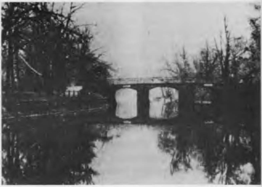
Rosa Luxemburg'un katilleri onun cesedini 15 Ocak 1919 gecesi Landwehr Kanalı'na atmışlardı. Rosa'nın cesedi kanaldan 31 Mayıs'ta çıkarıldı.
