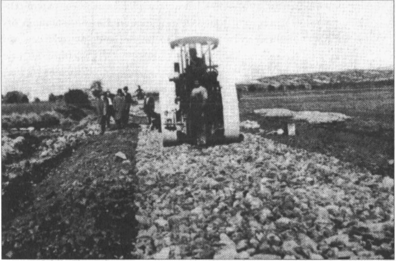
1940'lı yıllarda bir yol sıkıştırma çalışması.
