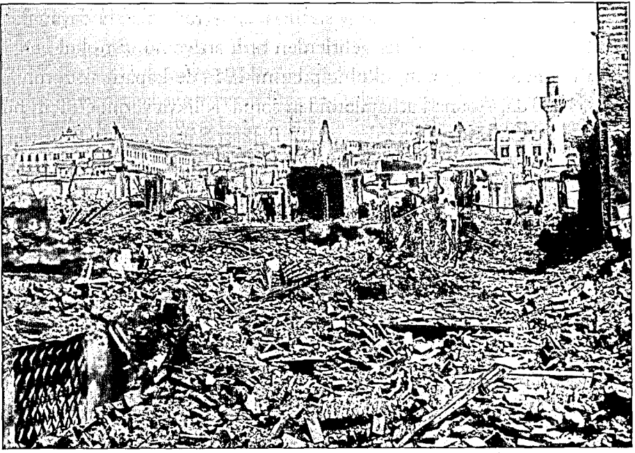
Yangında büyük hasar gören şehrin önemli yerleşim yerlerinden biri.
