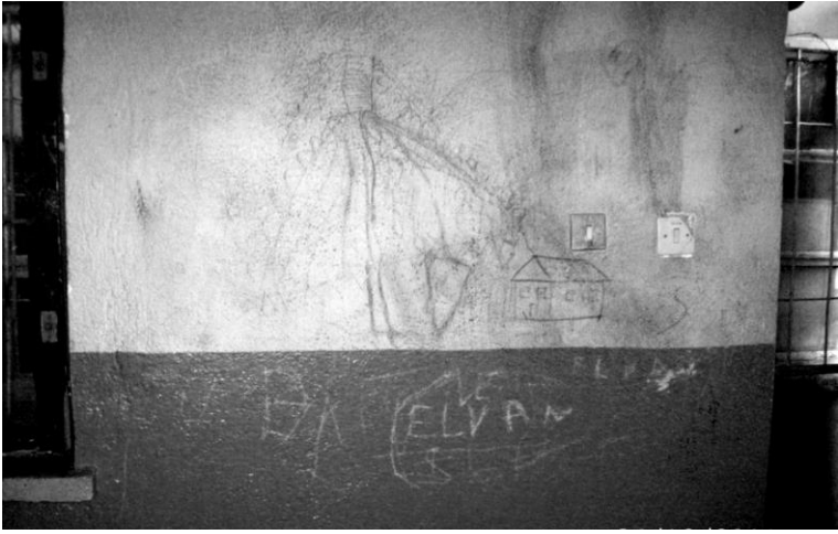
Resim 19: Barınağın içi- duvarlar.
