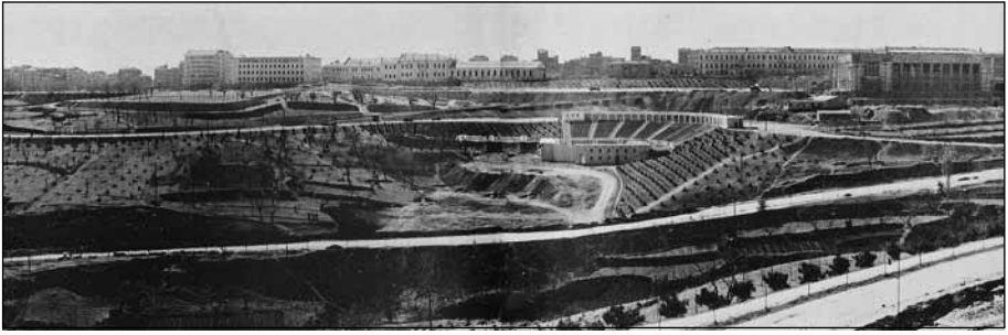
2 Nolu Park'ın Yapımı ve Açık Hava Tiyatrosu
