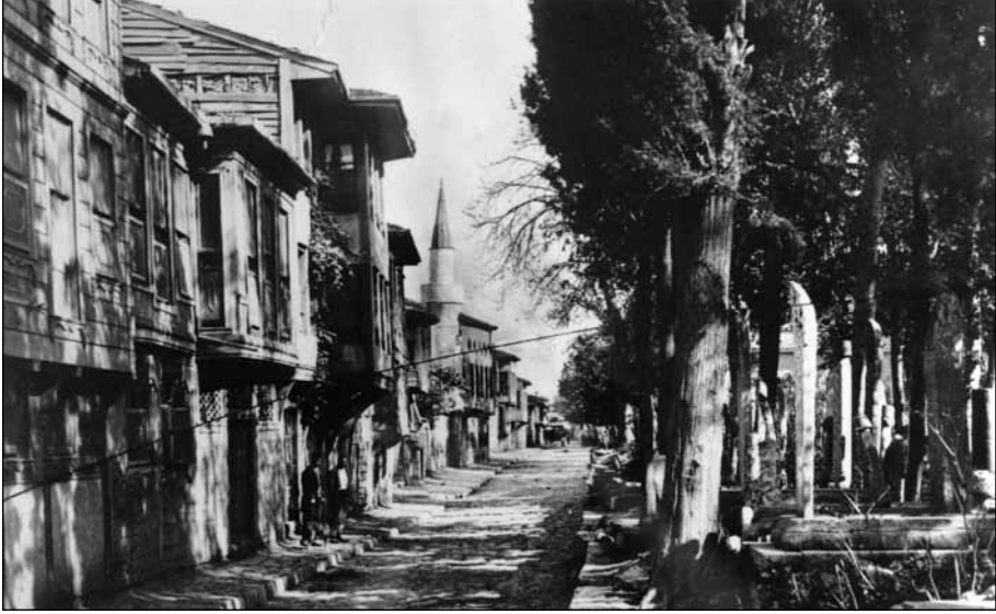
Yavud Mahallesi. Atatürk Köprüsü yapılırken ortadan kaldırılan, ahşap evleri, mezarlığı bodur minareli mescidiyle tipik bir İstanbul mahallesi (Süleyman Faruk Göncüoğlu Arşivi).
