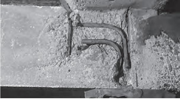
5.8'lik son depremin ardından İstanbul'da kontrol çalışmaları yapıldığı sırada binalarda korozyona bağlı hasarların olduğu anlaşıldı. Bu durum meydana gelecek 7 veya daha fazla büyüklükteki bir depremde ciddi sıkıntılar ortaya çıkacaktır.
