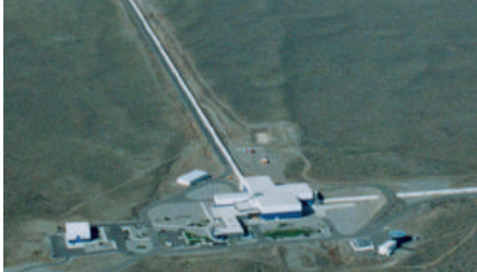
Resim 2. Hanford'da inşa edilen LIGO'nun havadan görüntüsü. Birbirine dik konumlandırılmış, lazer ışığının gelip-gittiği dörder kilometrelik iki kol görülebilir. Resim www.ligo.caltech.edu adresinden alınmıştır.
