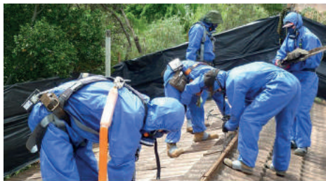
Şekil 2: Asbest söküm uzmanları usulüne uygun şekilde asbestli bir çatı sökerek
