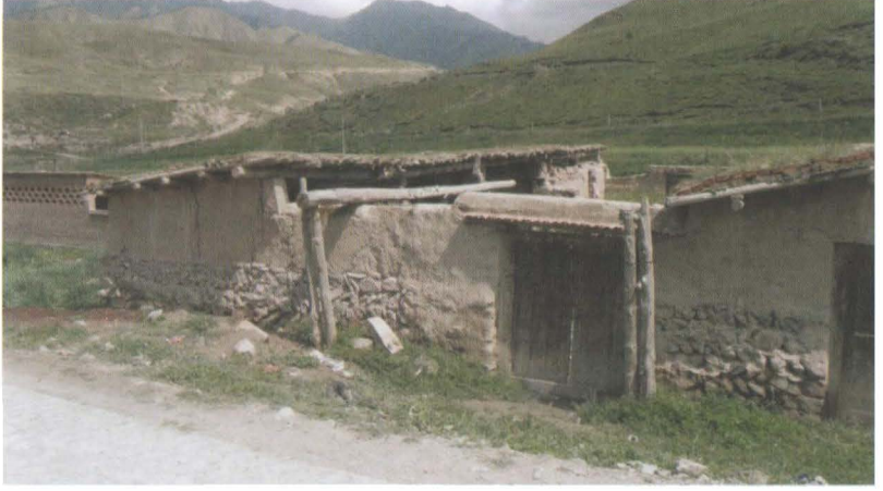
Resim-11. Kanglong Tapınağı'nın bulunduğu köyde kerpiçten yapılmış bir köy evi.
