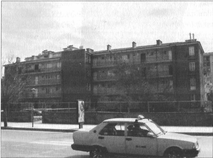
Seylap Sitesi'nin en "çalımlı" bloğu A Blok, dörtyol ağzına kurulmuş, işbilir bir müteahhidin eliyle çokkatlı ve ultra lüks bir binaya dönüşmeyi bekliyor
