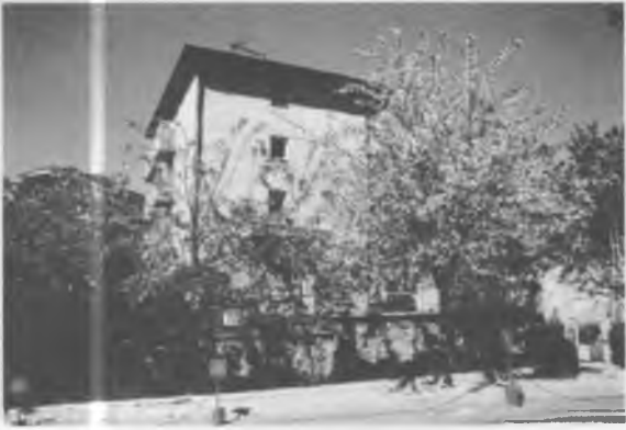
Cephesi Darphane binasına döndürülmüş lojmanın girişi
