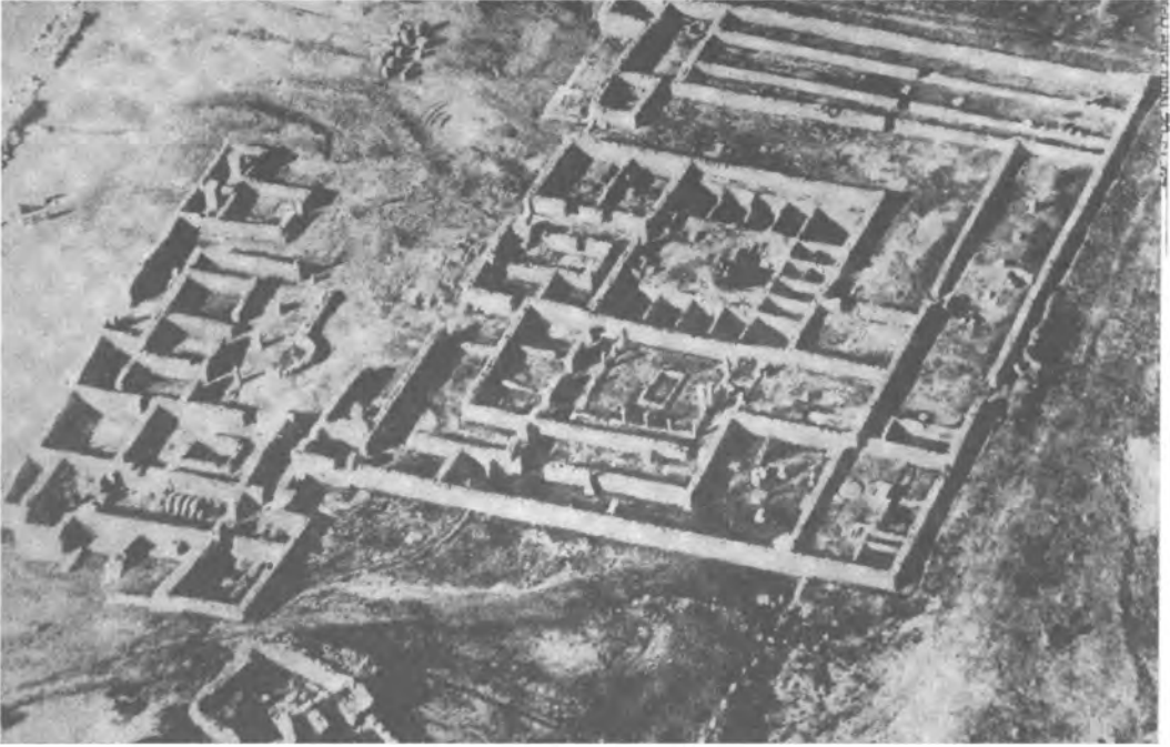
Resim 84. Romalıların kurduğu garum mayalandırma tesisinin görünümü. Kotta, Cezayir.
